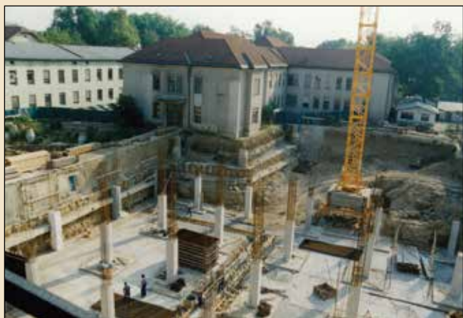
Gradnja objekta H
