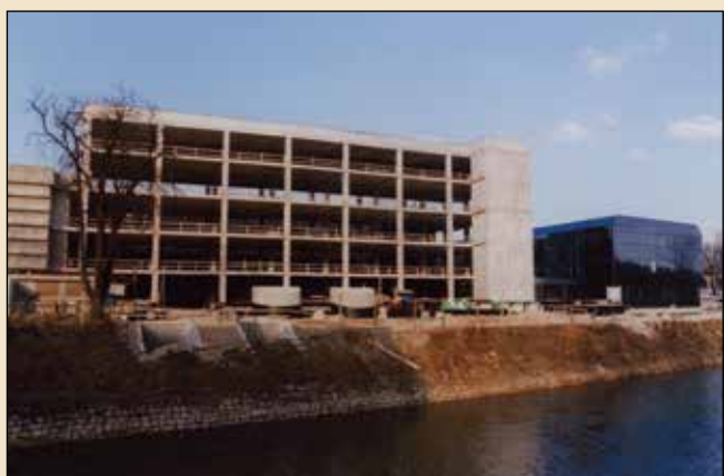
Gradnja 1. faze novega Onkološkega inštituta; pogodba s podjetjem SCT je bila podpisana leta 1996, gradnja je trajala 11 let
